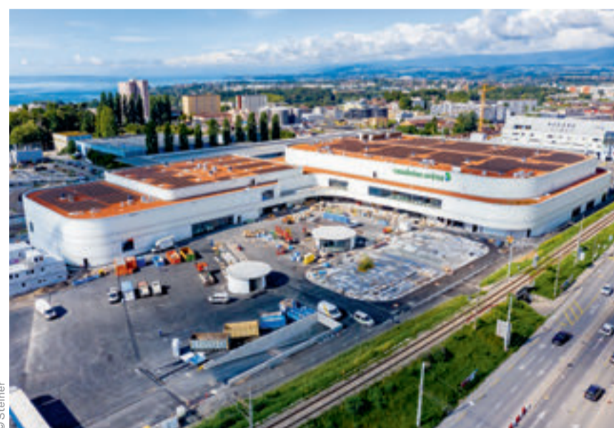
La Vaudoise aréna dispose d'installations de production de froid et de chaleur modernes et écologiques.
